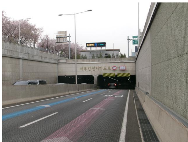
서부간선지하도로 성산방향 진입부
